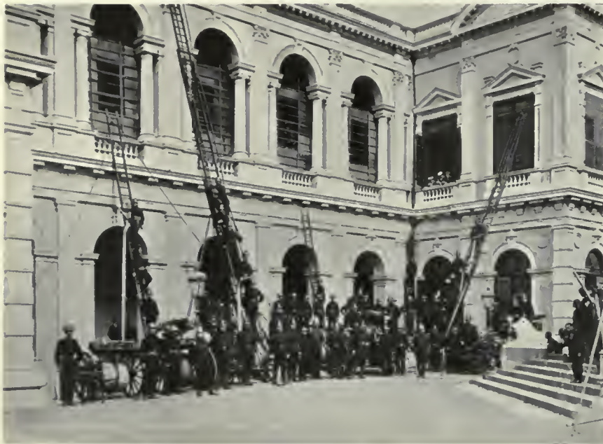
HONGKONG FIRE BRIGADE.
