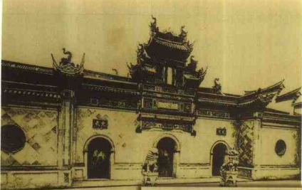
沪北钱业会馆落成于光绪十五年(1889)，占地十六亩，有前后两殿和两重戏台。在捐建和仪门上题联《三阳演义》、《五件》、《白蛇传》等人物形象。地址在今上海河南北路漕运路转角口东。
