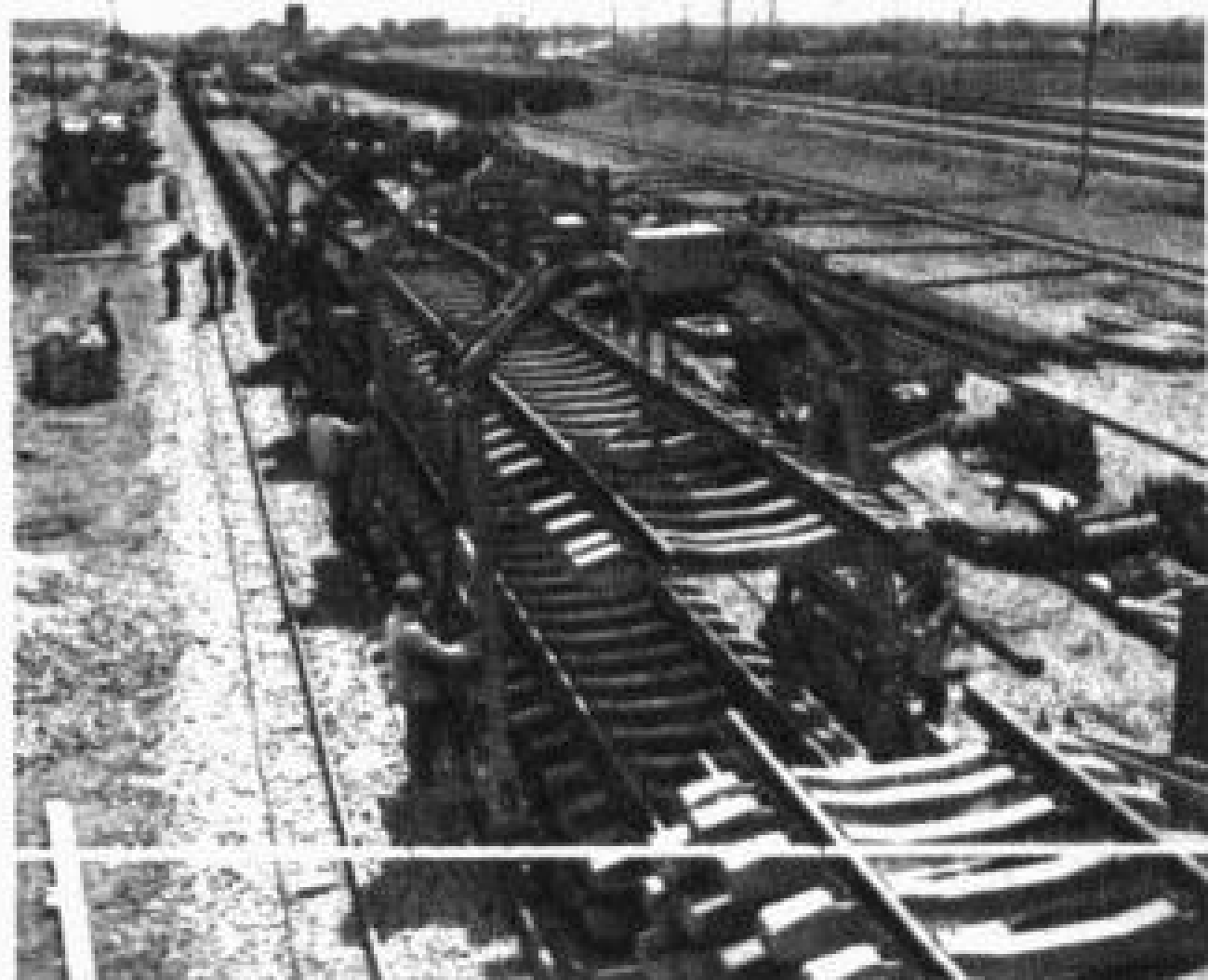
13. 机械铺轨 张伟生 胡根祥摄 光圈:f16 速度:1/125秒 海鸥4型,定21°全色胶卷。
