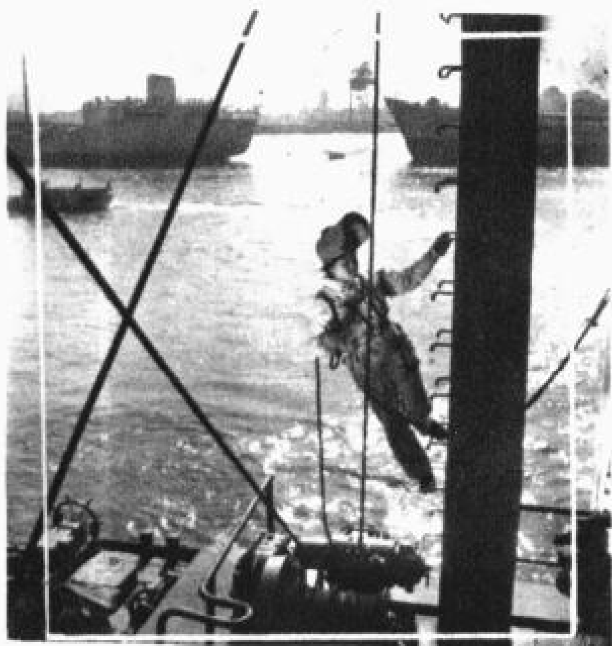
14. 航道女焊工 苏俊功摄 光圈:f8 速度:1/60秒 杂牌(旧)相机,定21°全色胶卷。
