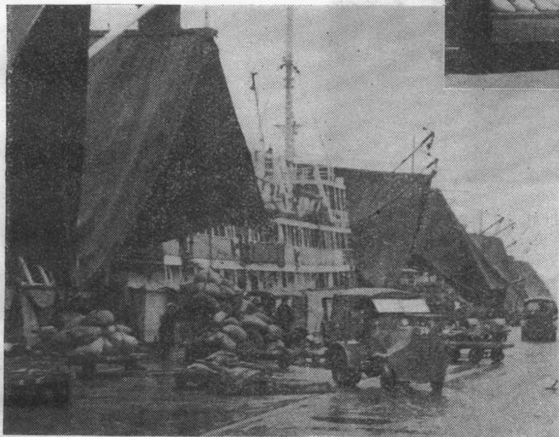
雨天不停工——雨天装卸使用开槽式雨篷
