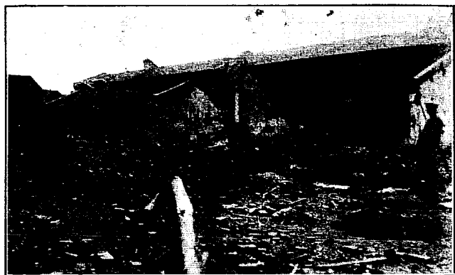
電話局材料處被燬情形
