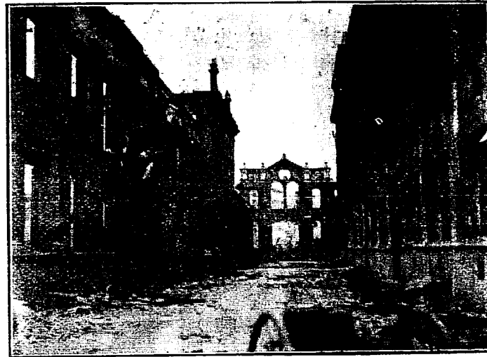
由總廠前門向內遠望危墻聳立情形
