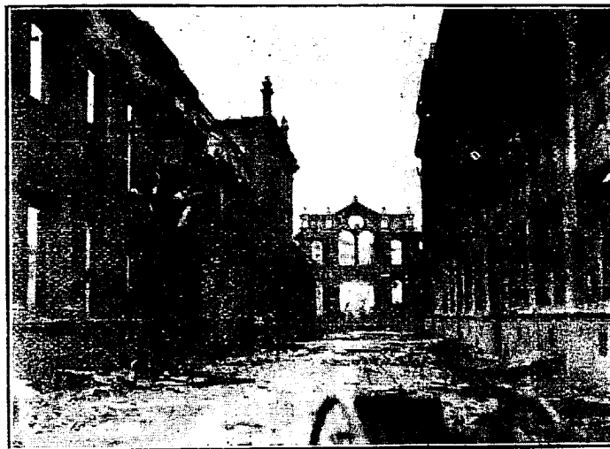
由總廠前門向內遠望危墻聳立情形
